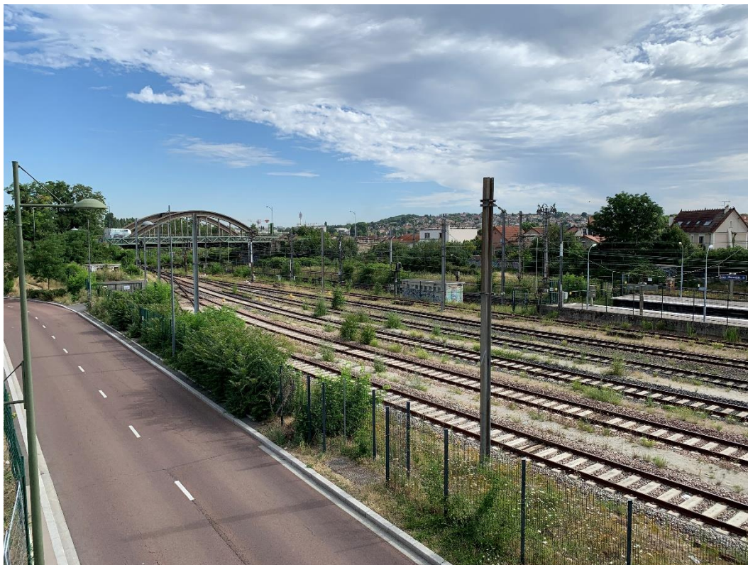
Photographie 16 : Vue des voies SNCF vers le Nord
