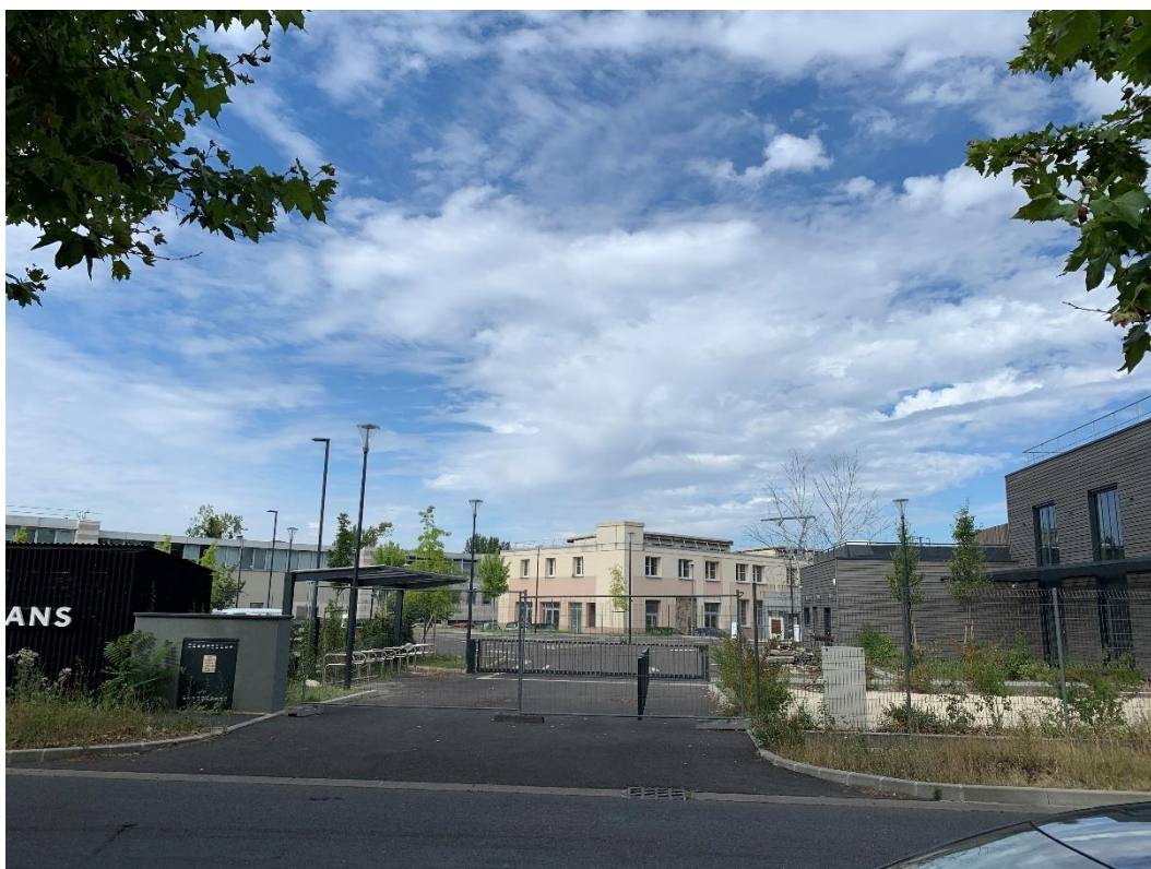
Photographie 4 : Vue des bâtiments localisés à l'Ouest de la parcelle étudiée
