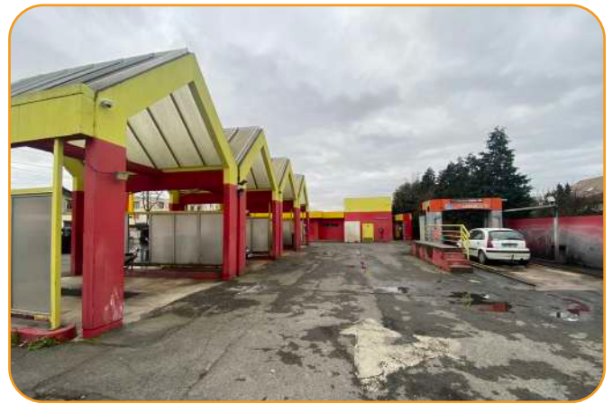
(6) - Photographie de la station service (source TRANS-FAIRE)
