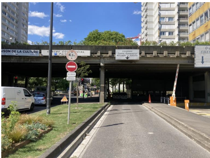
Passerelle démolie dans le cadre du NPNRU
