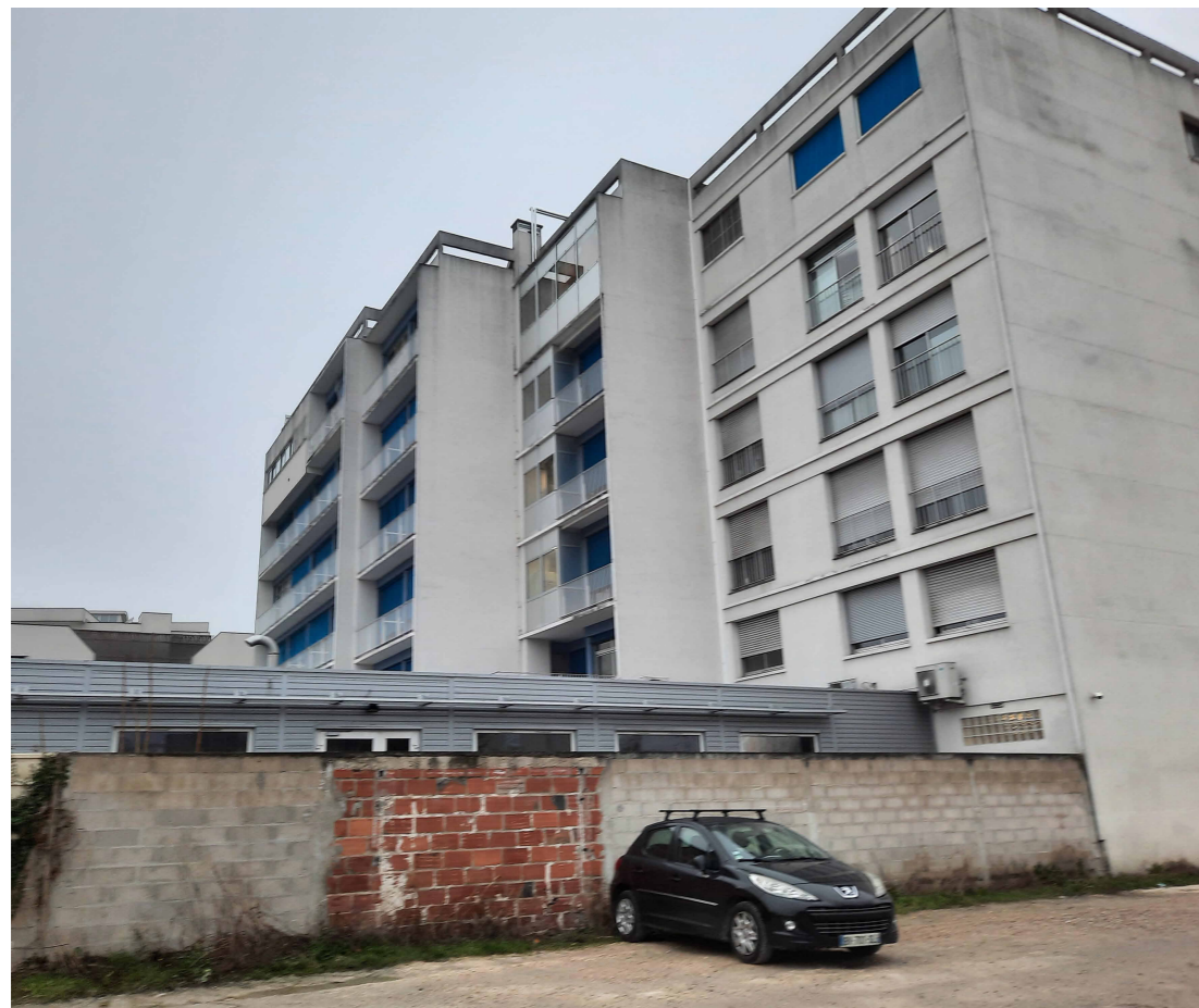
VUE 3 - DEPUIS PARKING DECEMBRE 2021
