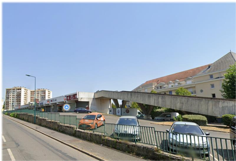
Vue état existant, Street View
