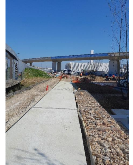
13 : vue vers le site (à gauche) depuis le chantier de la ligne T18
