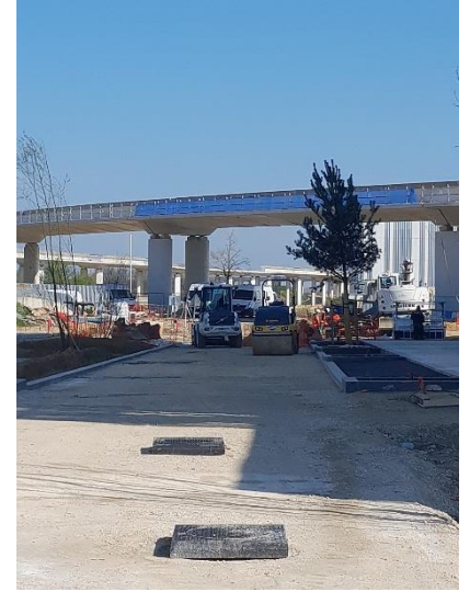
35 : chantier de la future ligne 18
