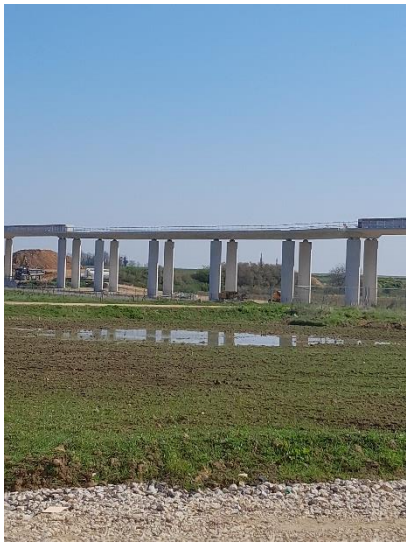
36 : chantier de la future ligne 18
