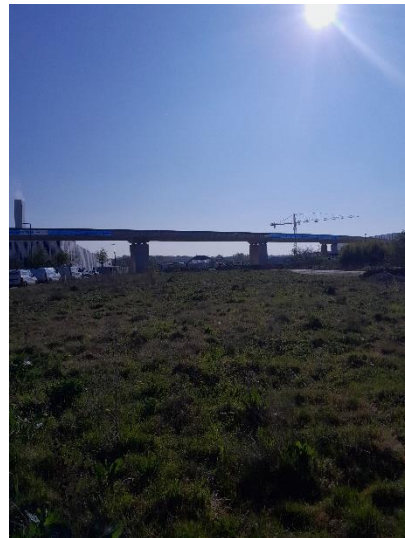
6 : Vue prise depuis l'Ouest du site vers le chantier de la ligne 18
