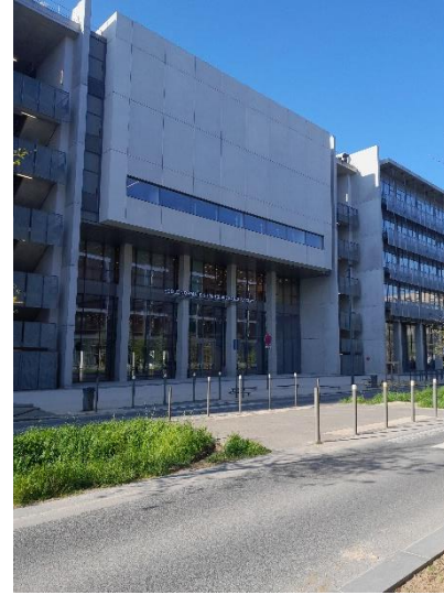
18 : L'Ecole Normale Supérieure, entrée Nord
