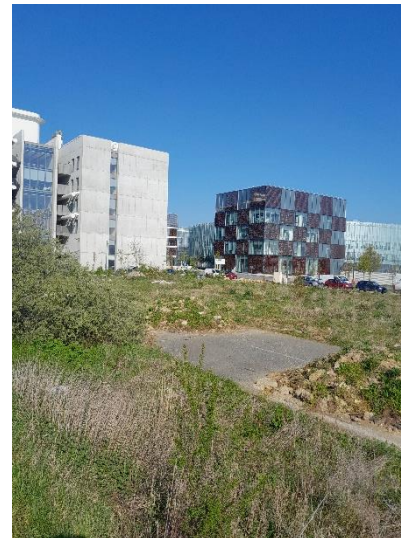
7 : Vue prise depuis le Sud-Est, l'Ecole Normale Supérieure et le bâtiment Servier
