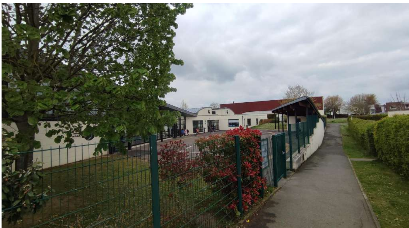
Figure 5 : Vue depuis la rue des verts près
