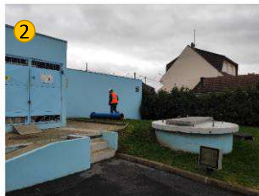
Vue sur forage F11 « Jaurès »
