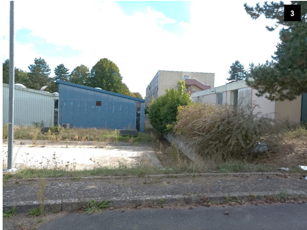
Figures 3, 4, 5 : Vues depuis l'intérieur du site
