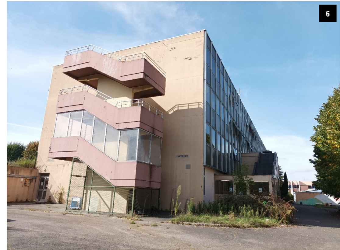
Figures 6, 7: Vues depuis l'intérieur du site
