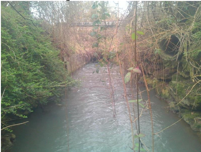
Point 3 : Exutoire eau pluviale en aval du pont
