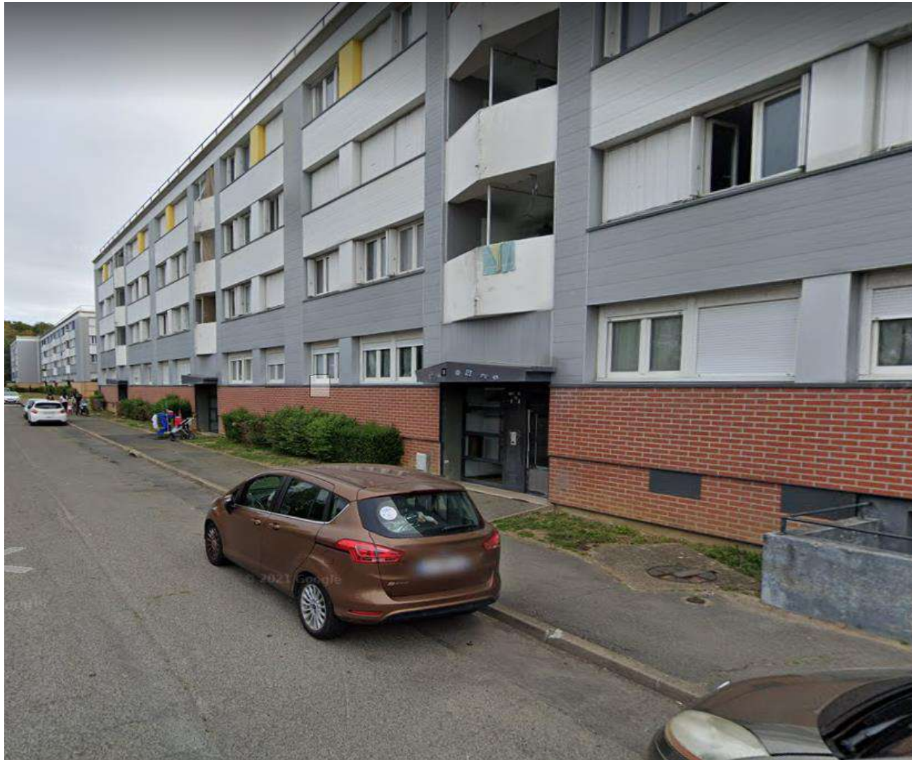
Photo 2 : depuis la rue du Moulin Joli (4 Novembre 2022)
