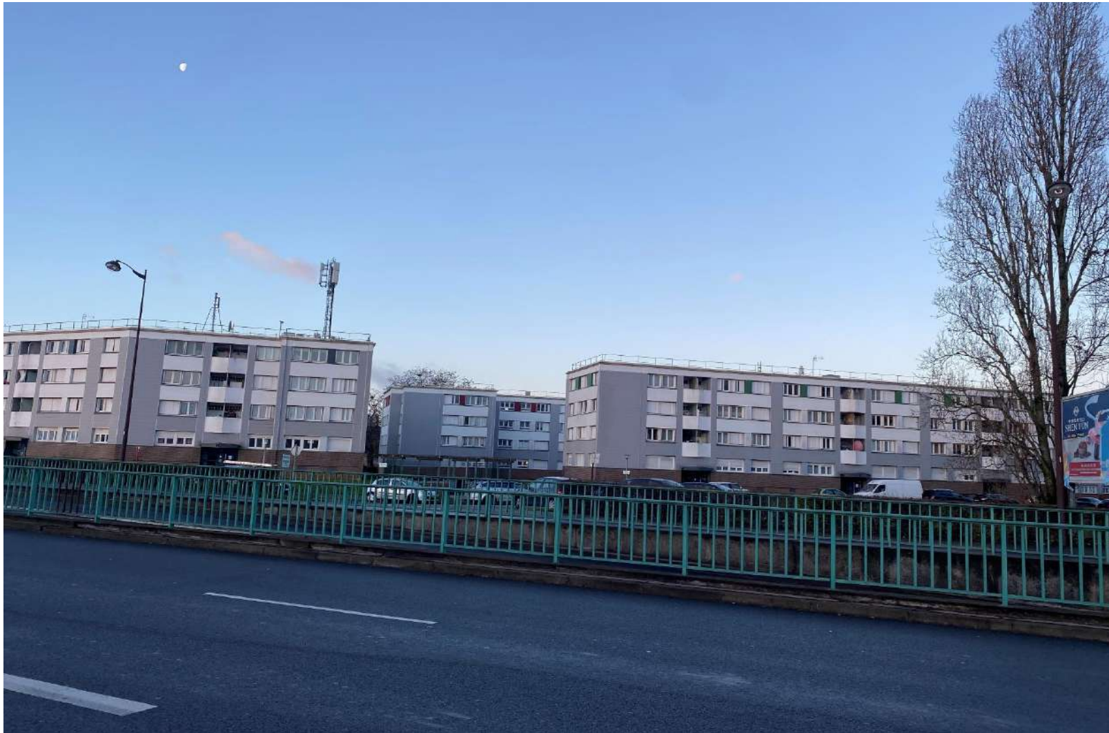
Photo 3 : prise de vue lointaine de l'entrée de la résidence (13/01/2023)
