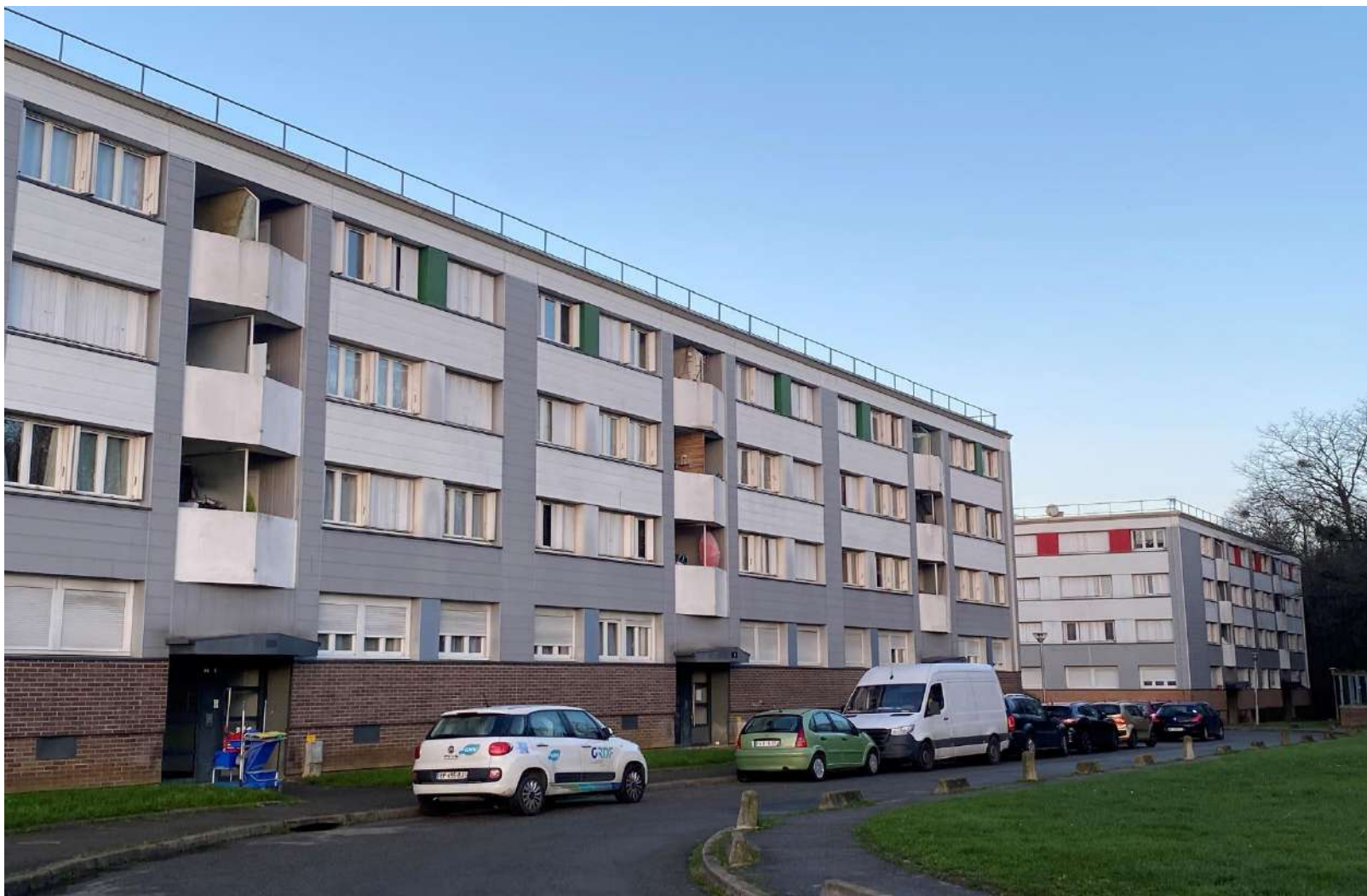
Photo 4 : prise de depuis la rue Poirier Piquet depuis l'entrée de la résidence (13/01/2023)
