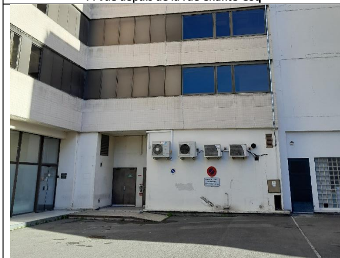
7 : cours sur l'arri  re de l'immeuble
