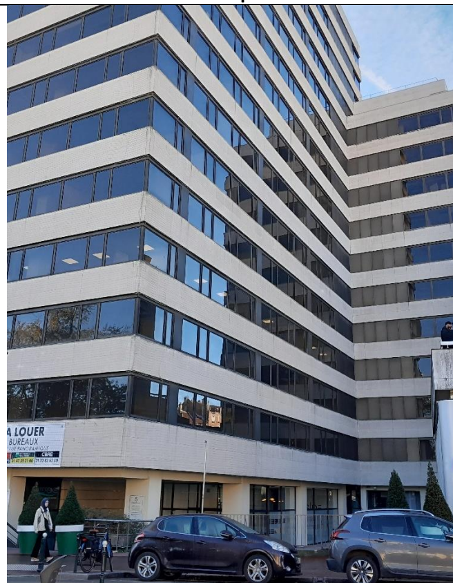
2 : le bâtiment A, au droit de la rue Chante Coq
