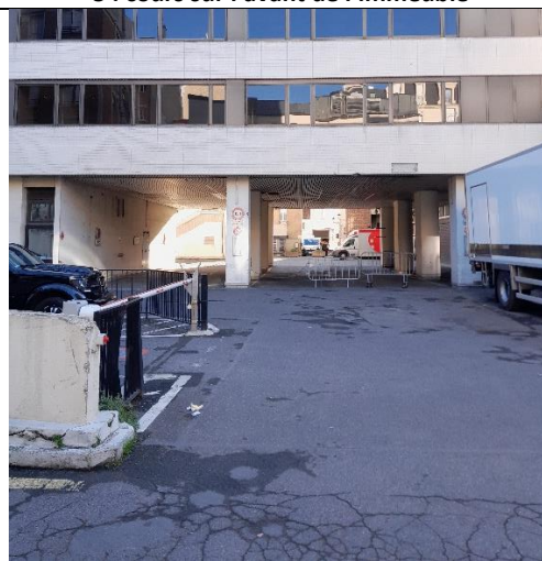
8 : cours sur l'arri  re de l'immeuble
