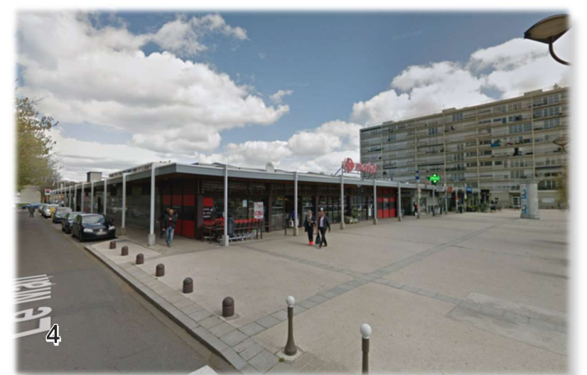
Vue sur le Centre commercial du Mail au nord du site
