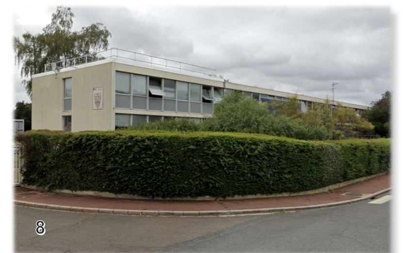
Vue sur un des immeubles du site de la C.R.S. à proximité de son entrée en bordure de l'avenue Sadi Lecointe
