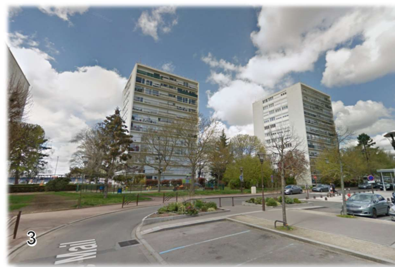
Vue sur les immeubles de logements au nord-ouest du site
