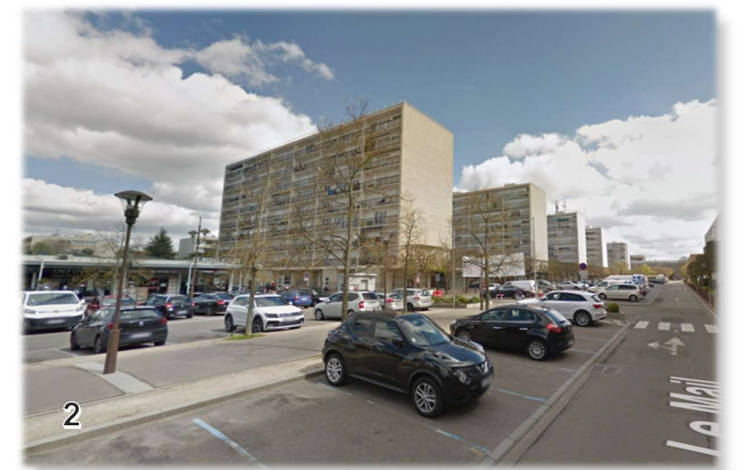
Vue sur les espaces de stationnement du Mail et sur le tissu urbain au nord (logements, commerces, activités)
