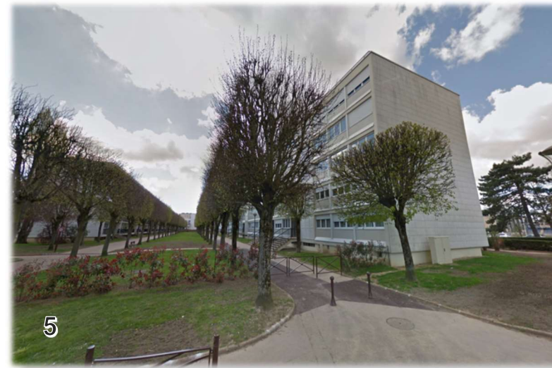
Vue sur l'immeuble de logements voisin au sud-ouest du site depuis l'extrémité ouest du Mail
