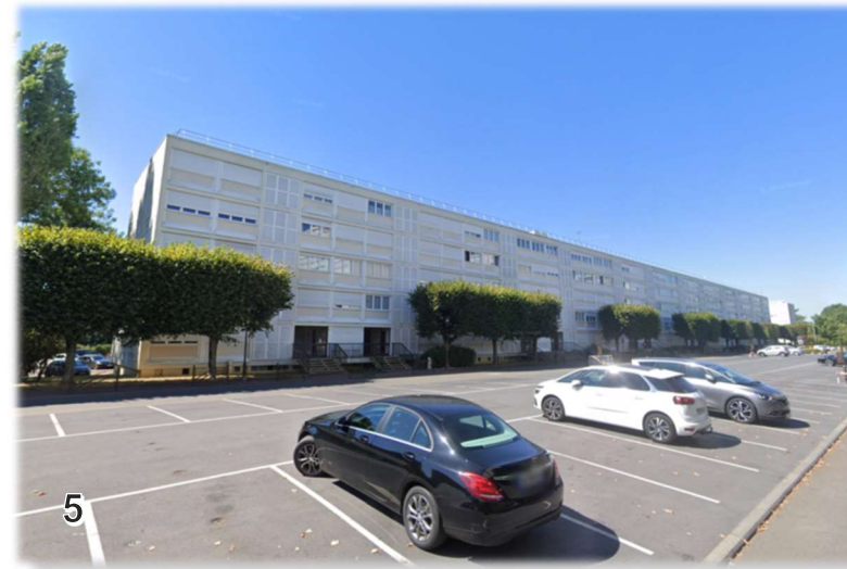
Vue sur l'immeuble de logements depuis le Mail au nord
