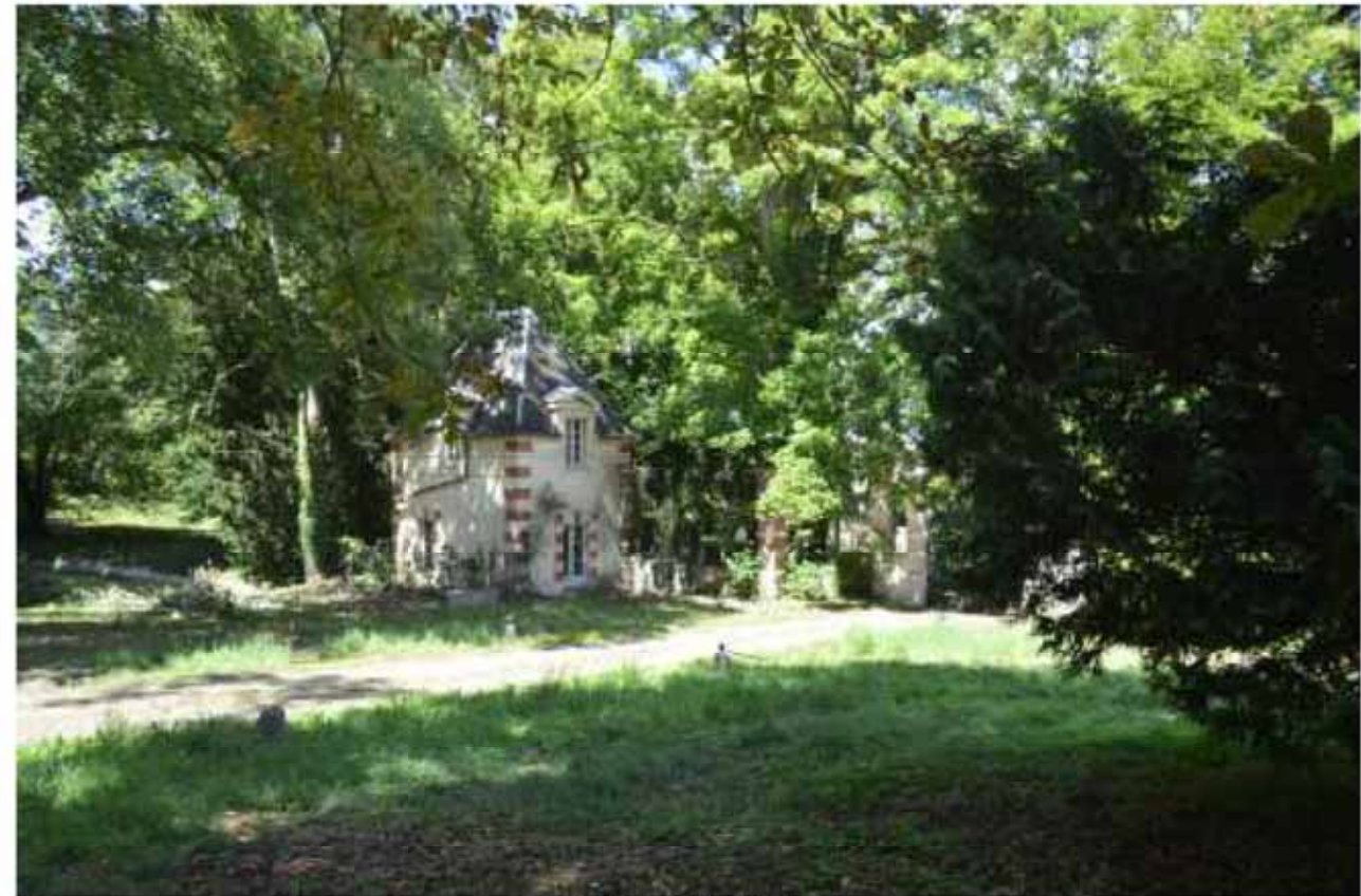
PC 7.8 PAVILLON DE GARDE (juillet 2022)
