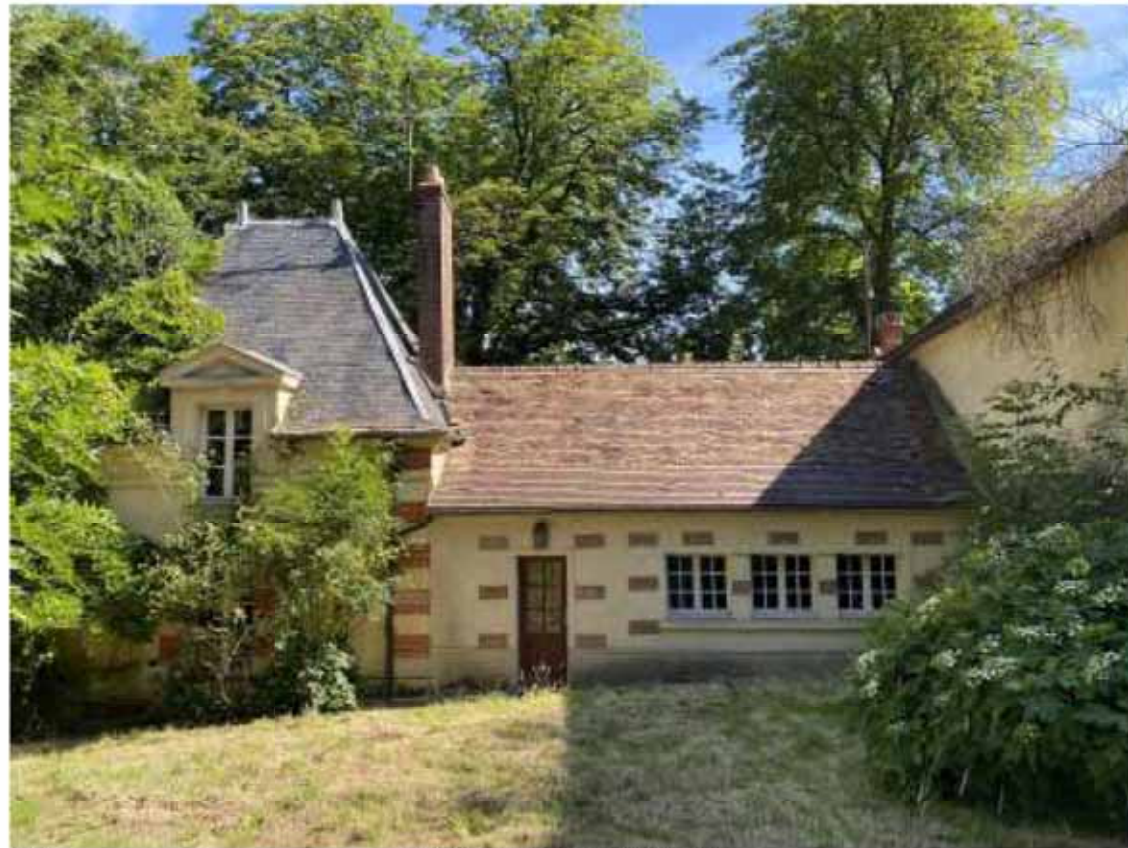
PC 7.7 PAVILLON DE L'ÉCUYER, FACADE SUD (juillet 2022)
