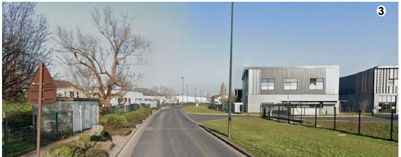
Abord du site avec vue Sud-Ouest vers Nord-Est sur la N184 _ Source : Google Earth, 2023
