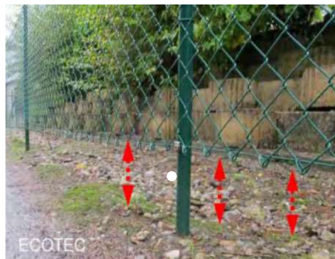
Exemple de clôtures permettant le passage de la petite faune @Ecotec
