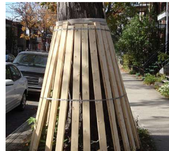
Protection des arbres en phase travaux © Ville de Montréal
