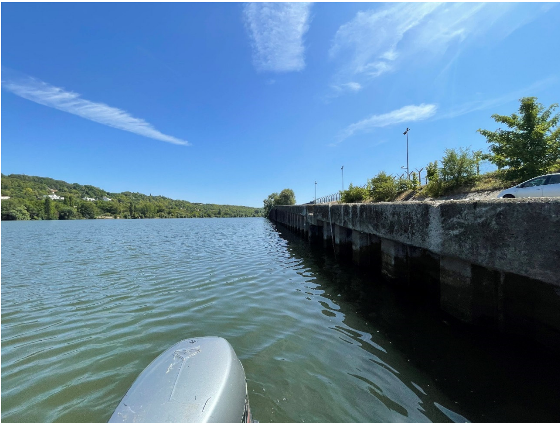
Figure 5. Photographies du site : devant le quai
