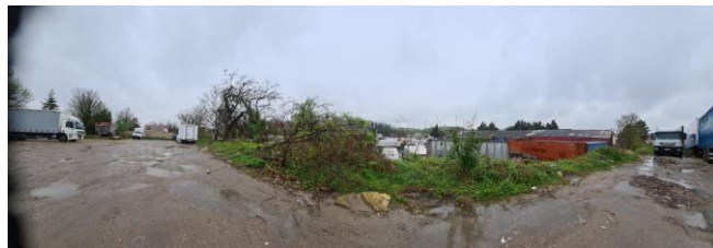
H Zone de remblais
