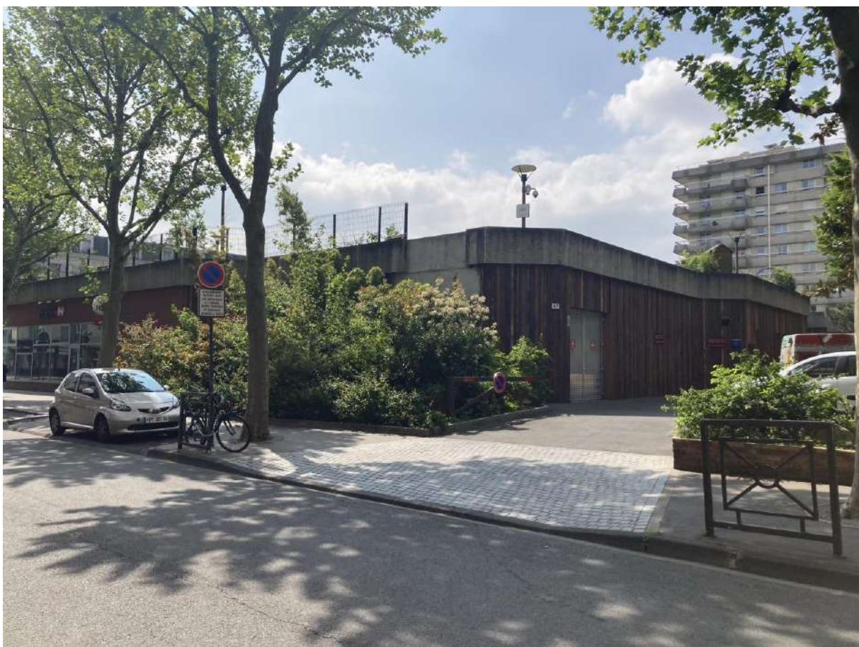
Photo de l'arrière du bâtiment existant, depuis l'avenue du château prolongée (3)
