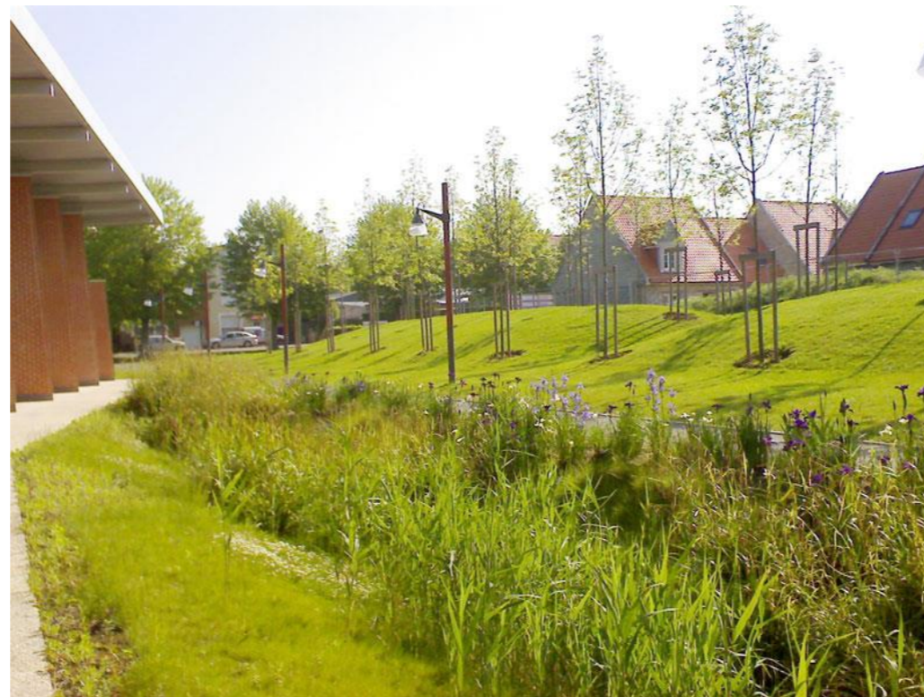
Vue sur un exemple de noue paysagère
