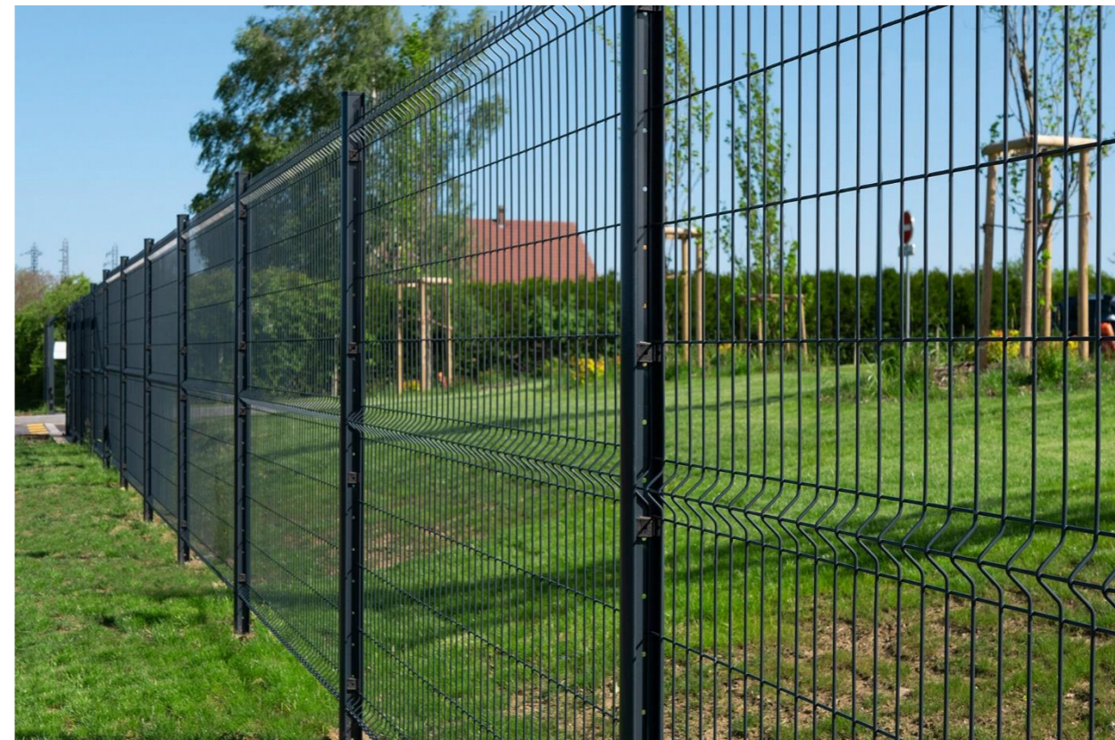
Exemple de modèle en treillis soudé envisagé
