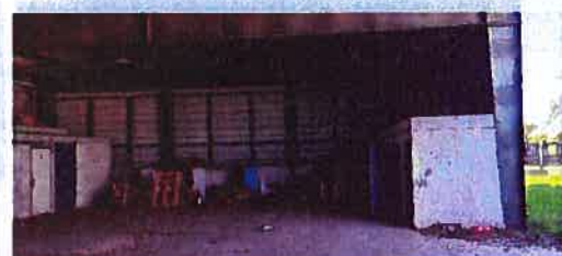
Vue 13 : intérieur du hangar
