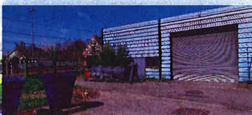
Vue 14 : vue du hangar Nord-Ouest
