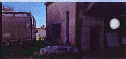
Vue 12 : entrée du hangar près de la station-service
