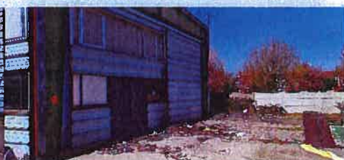
Vue 15 : bâtiments Nord
