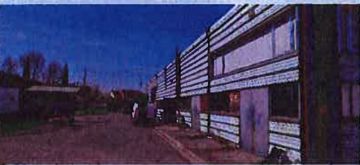
Vue 8 : hangars au Nord-Ouest
