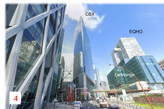
Vue depuis le boulevard Patrick Devedjian sur la tour CBX au sud-ouest de l'immeuble Le Monge
