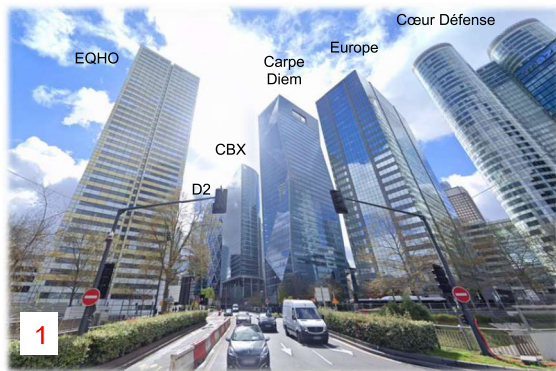
Vue en direction du sud-est sur les IGH situés en bordure du boulevard Patrick Devedjian à proximité du site
