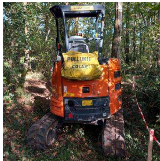
Figure 17 : Kit anti-pollution sur un chantier de mesures compensatoires près d'Angers ©ARP-astrance 2022
