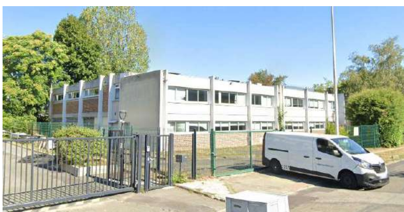
Photos du site de projet (Source : Googlestreetview, août 2022)
