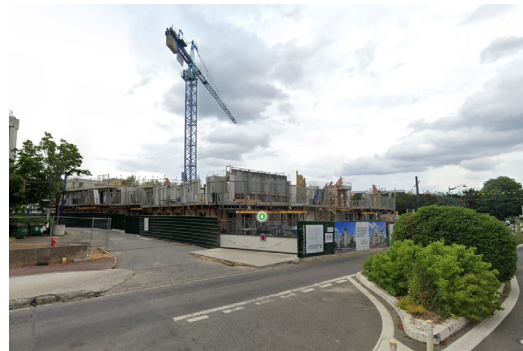
Travaux en cours sur le Parc Technologique (source : googleearth)
