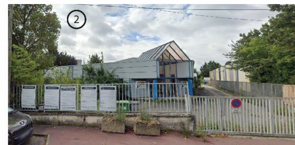
Entreprise IDP Démolition - D3 environnement (PC en cours)
