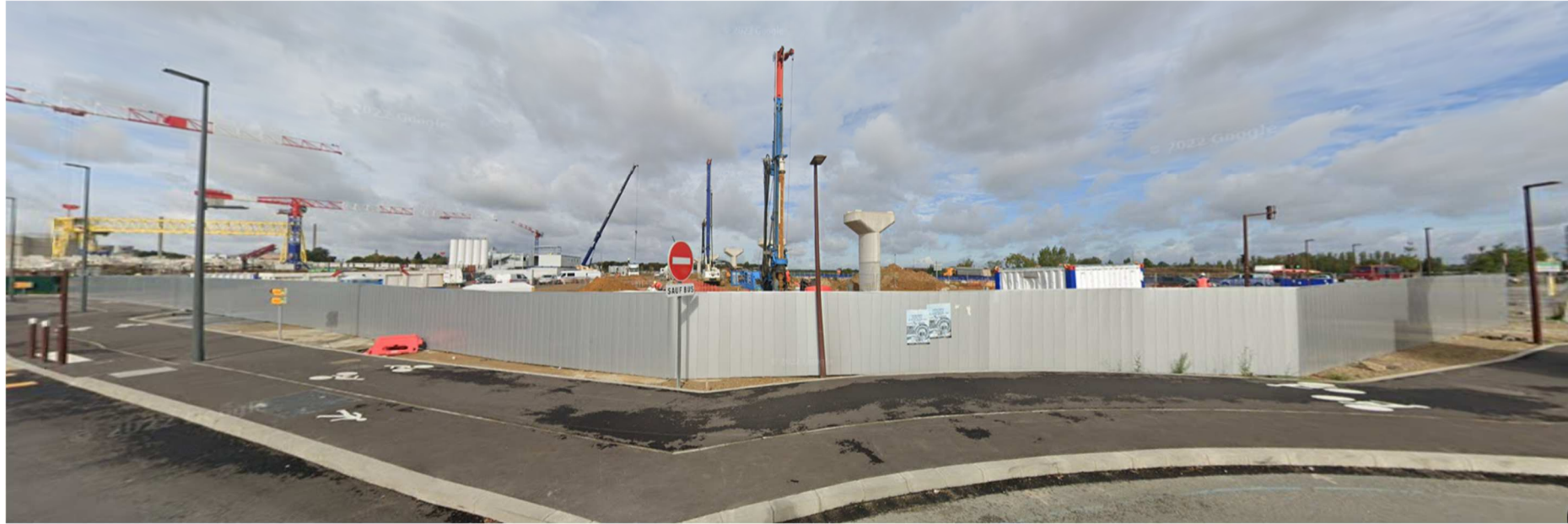
Vue depuis le carrefour du Christ (site occupé, chantier SGP de la gare ligne 18 de CEA Saint-Aubin) – prise de vue septembre 2022
