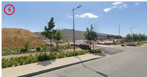
Site en chantier
