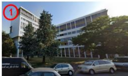
Bâtiment d'activités tertiaires
