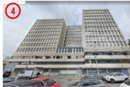
Maison Départementale des Personnes Handicapées Val-de-Marne
