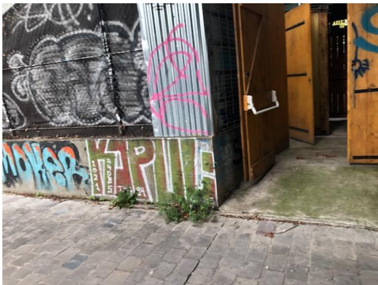
Accès PMR longeant le canal de l'Ourcq (Even Conseil, novembre 2022)
