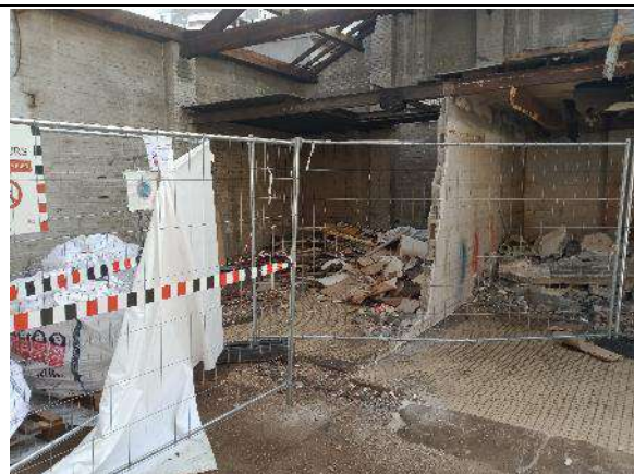
Parcelles 535 et 536 – Vue du stockage des gravats de démolition
