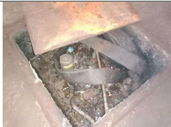
Parcelles 535 et 536 – Vue de la cuve après ouverture
