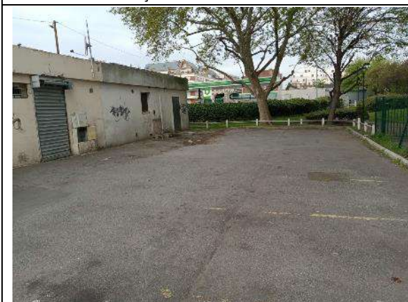
Vue de l'arrière du bâtiment de commerce
