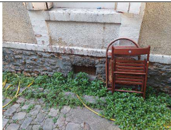
Parcelle 159 – Vue de la façade du pavillon
