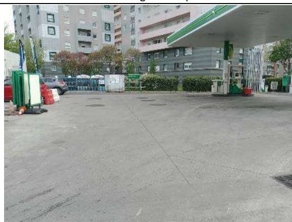
Vue des regards suspects et du stockage de bouteilles de gaz
