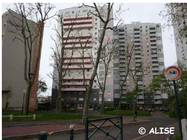
Photo 1 : Immeubles et alignements d'arbres en bordure de voirie
