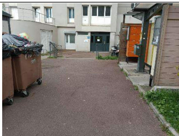
Vue de la façade du bâtiment de logement
