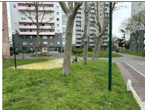
Vue de l'arrière du bâtiment de logement
