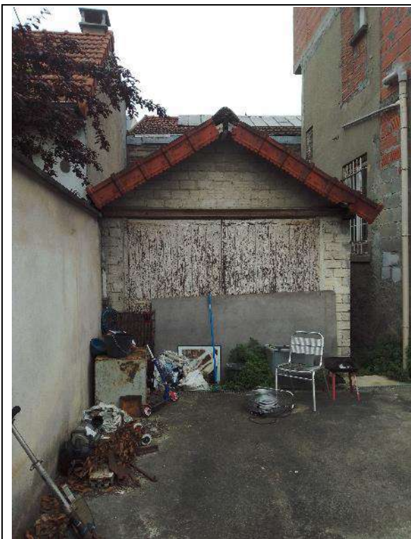
Parcelle 156 – Vue de la remise
