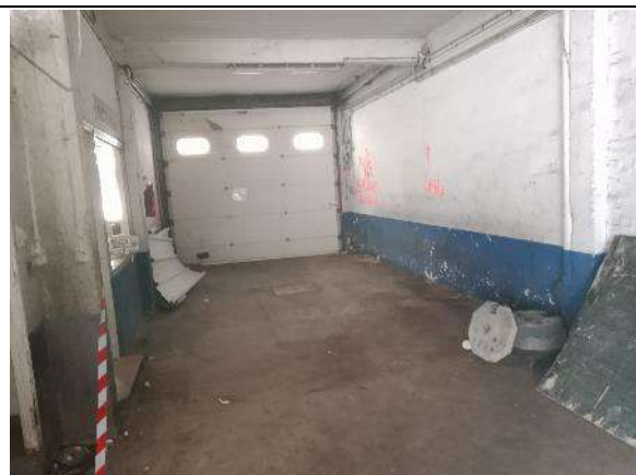
Parcelles 535 et 536 – Vue de l'allée du garage
