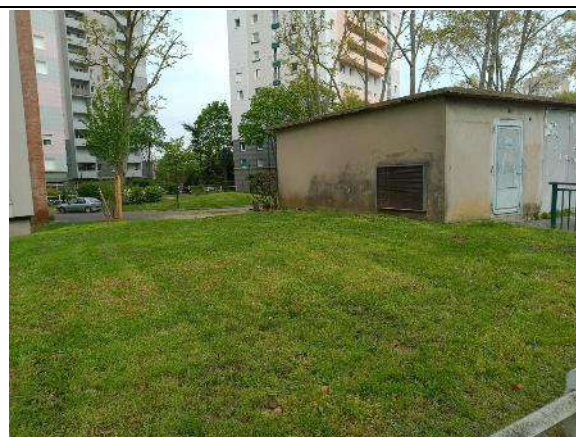
Vue du transformateur électrique
