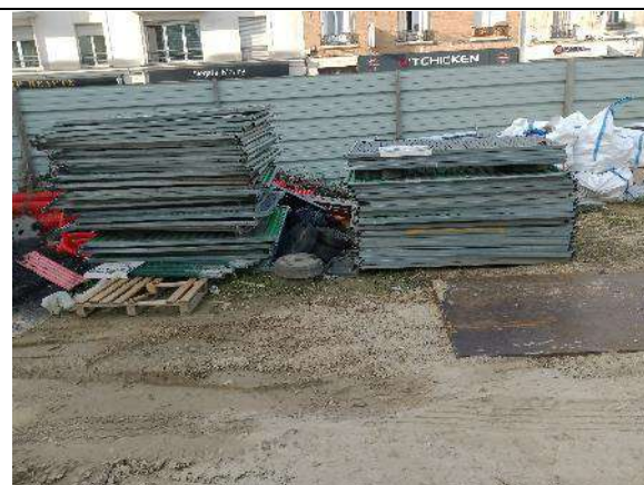
Parcelle 237 – Vue du stockage de matériaux de construction
