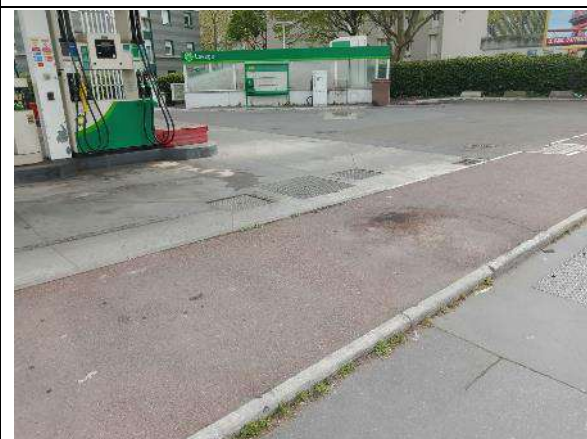
Vue des regards suspects et de l'aire de lavage
