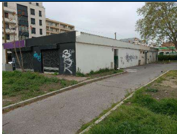
Vue de l'arrière du bâtiment de commerce
