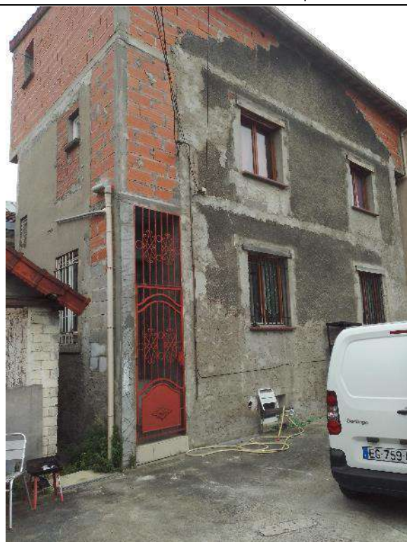
Parcelle 156 – Vue du bâtiment
