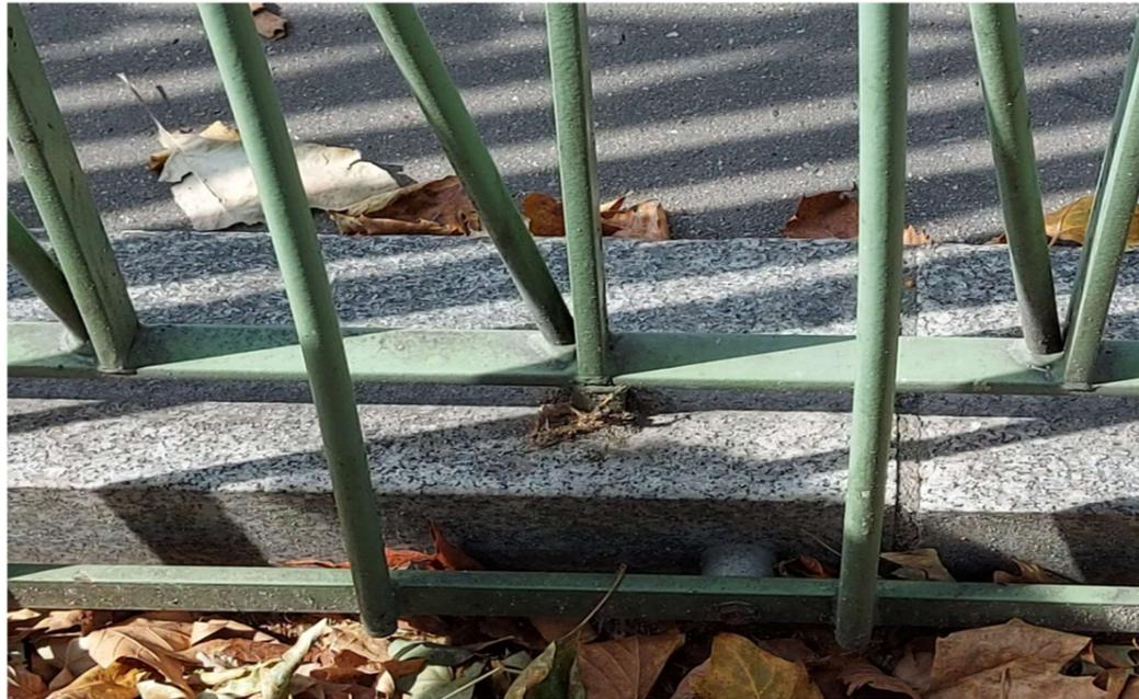
Figure 31 : Photographie des détails du scellements des clôtures aux longrines – Source : Ville de Paris
