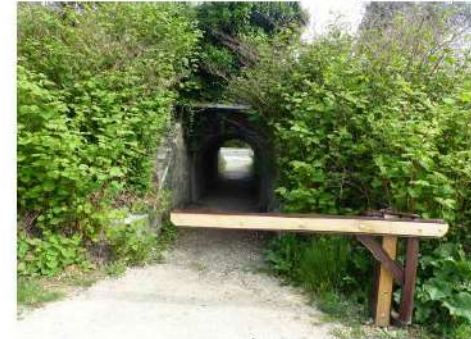
Passage sous-terrain dans remblais, entre la promenade en bord de Marne et rue de Dampmart
