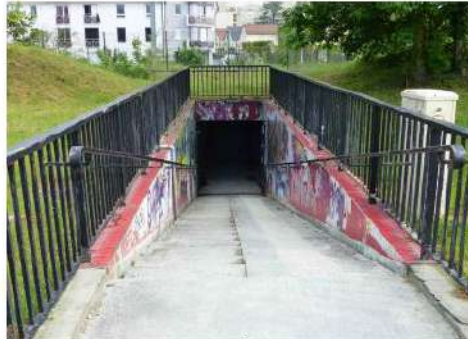
Passage sous-terrain dans remblais, entre la Grande Prairie et rue Raymond Poicaré
