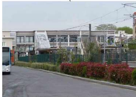
Passage supérieur voies ferrées, Gare de Thorigny/Lagny
