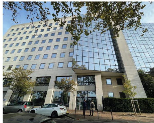
Figure 8 : Façade du bâtiment
