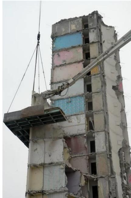
*Exemple de démolition avec utilisation d'une plate-forme de protection*
