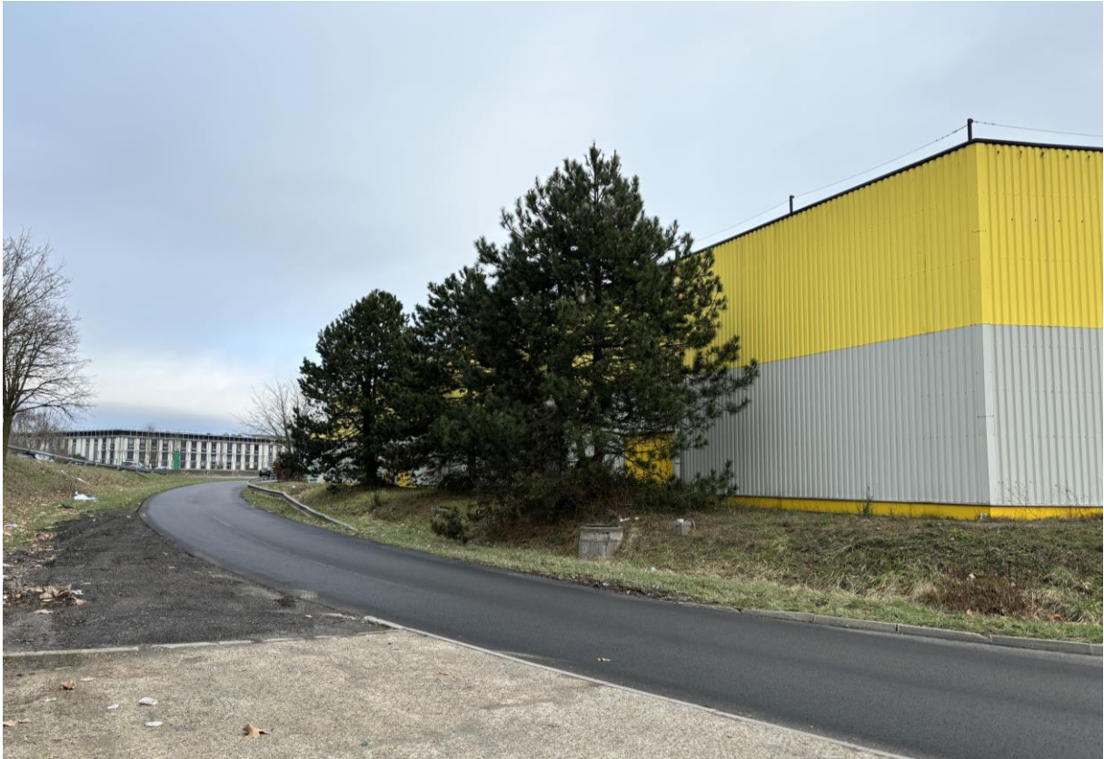
8 : Vue sur la façade Nord-nord-ouest du bâtiment avec au premier plan la voie permettant de rejoindre la RD 118 avenue de l'Océanie en direction de l'Est (prise de vue du 22 janvier 2024). Cette voie (voie à sens unique) contourne le site du Sud au Nord en passant par l'Ouest.
