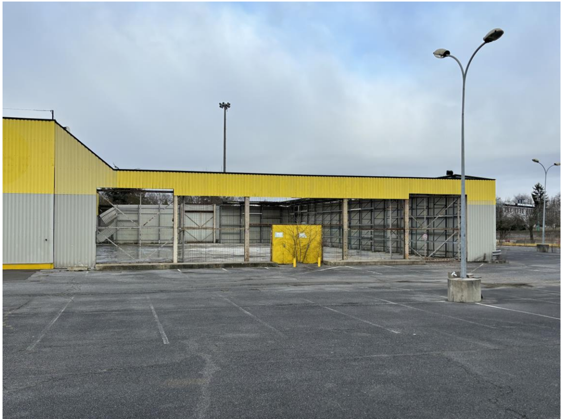
5 : Vue sur l'ancienne cours matériaux du bâtiment commercial en friche et le parking au premier plan (prise de vue du 22 janvier 2024)
