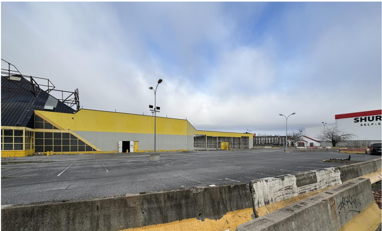
9 : Vue sur la zone de parking à l'avant de l'ancien bâtiment commercial (prise de vue du 22 janvier 2024)
