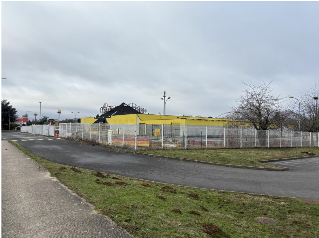
4 : Vue sur le site depuis l'Est (prise de vue du 22 janvier 2024)
