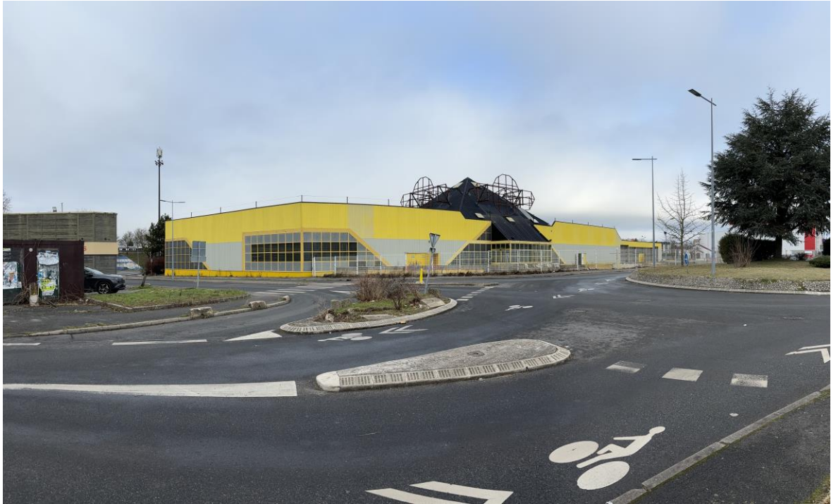
6 : Vue sur l'ancien bâtiment commercial depuis le Sud (prise de vue du 22 janvier 2024)
