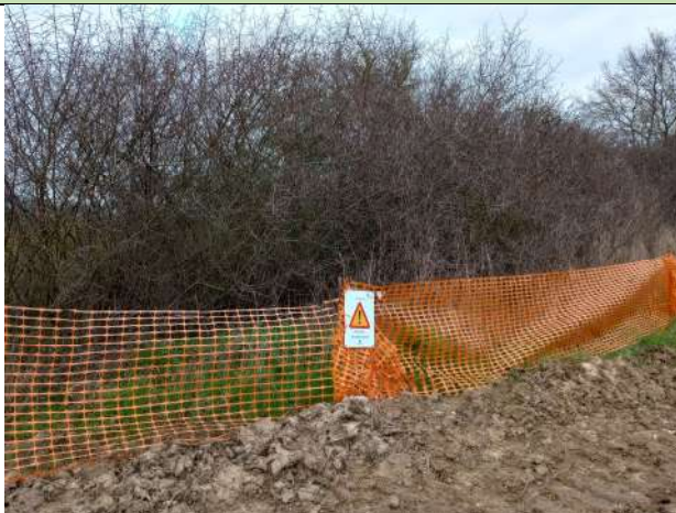
FIGURE 2 : BALISAGE DE CHANTIER
