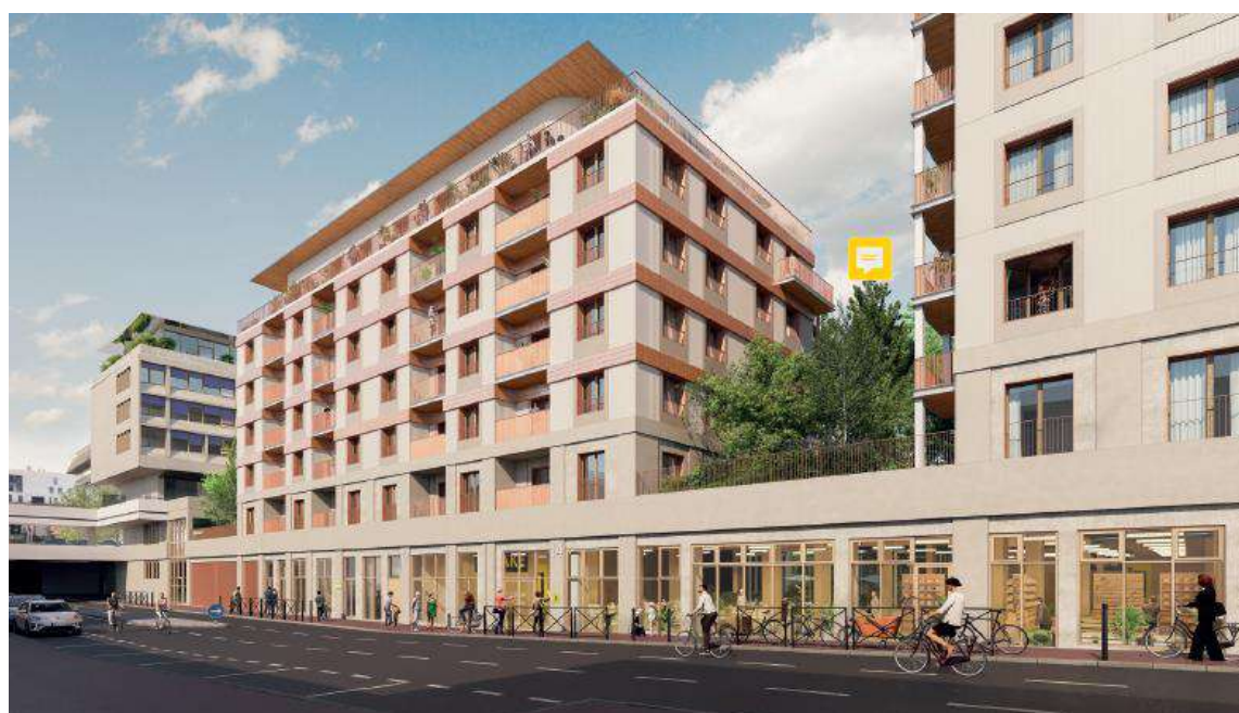
Vue depuis la rue de la Préfecture : état projeté (Woodeum)
