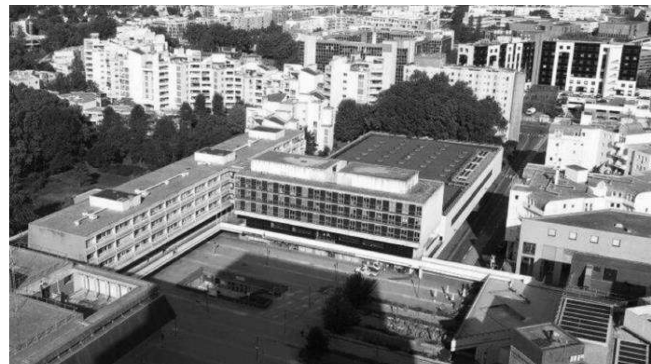
Ensemble immobilier de la piscine-patinoire (Woodeum)
