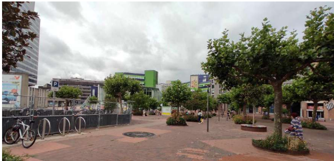
Vue sur la dalle - Place du Général de Gaulle, pendant les travaux (MEDIATERRE Conseil)
