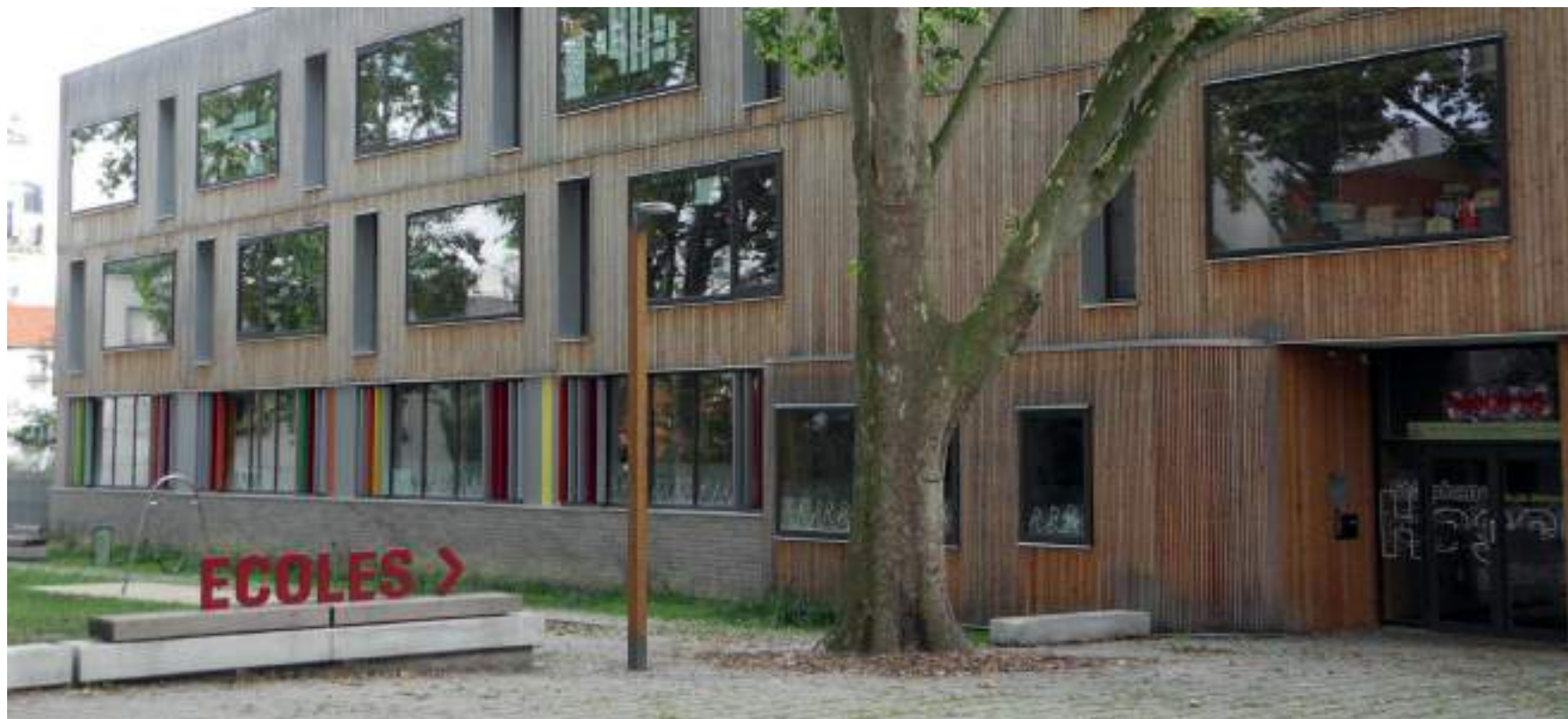
→ École Stéphane Hessel à Montreuil, construite en bois et isolée en paille, Méandre Architecture.
