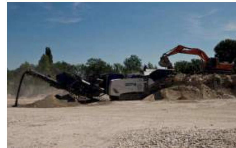
→ Installation mobile de concassage des matériaux de déconstruction
