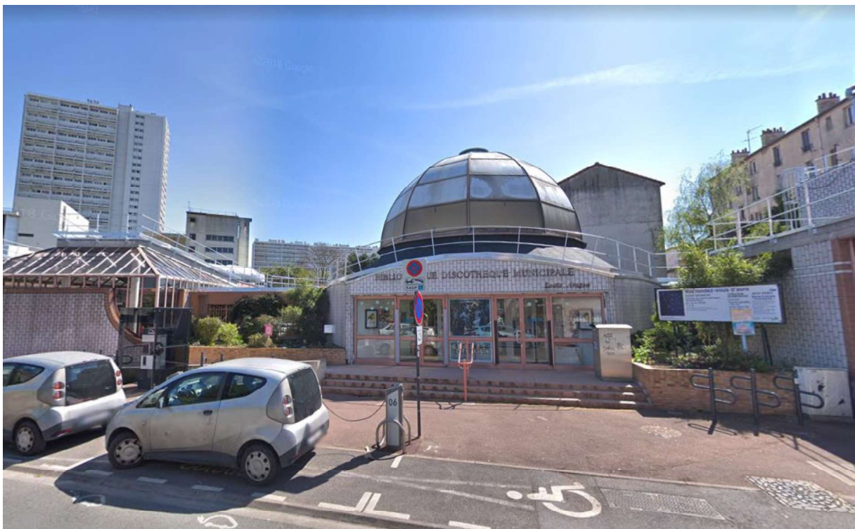
2 : Vue sur la médiathèque, avenue Rabelais
