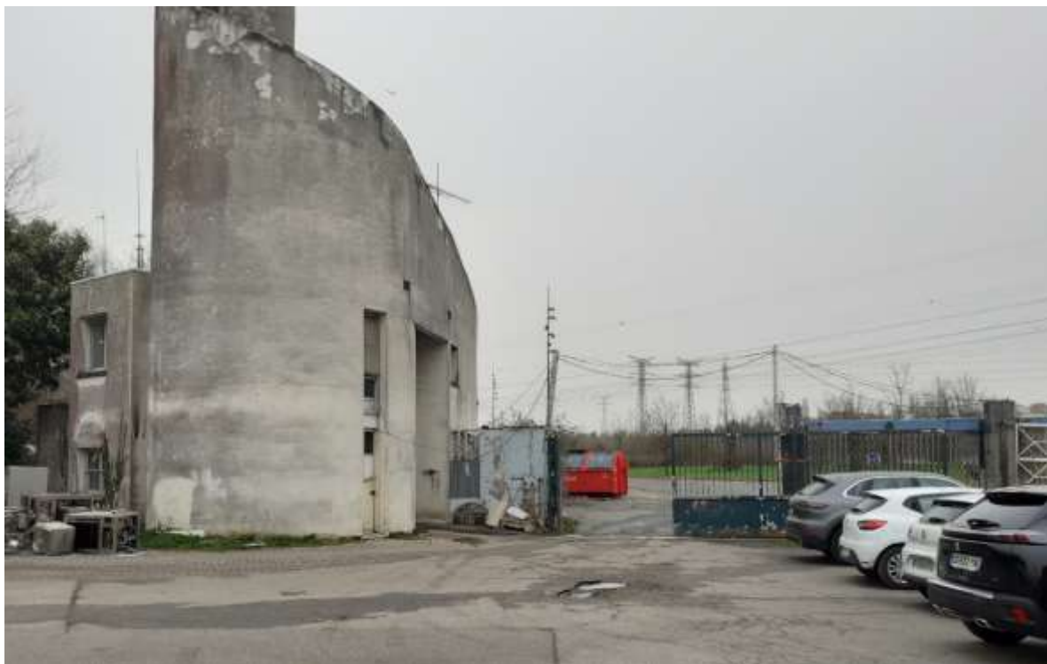
Photographie 1 : Entrée du site d'étude (accès est)
