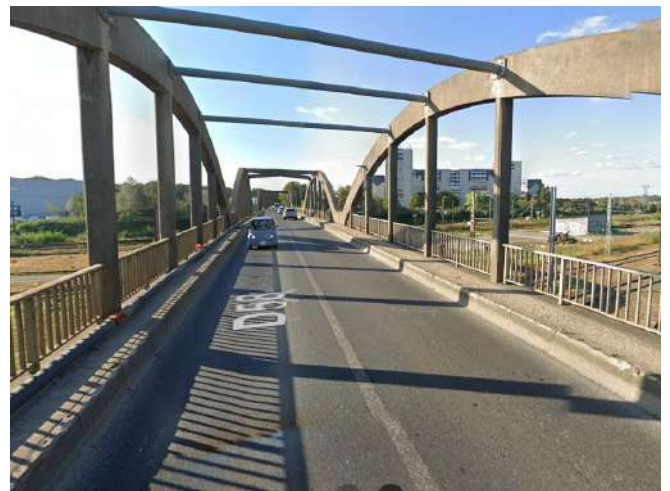
7. Traversée de l'ouvrage de franchissement des voies ferrées
