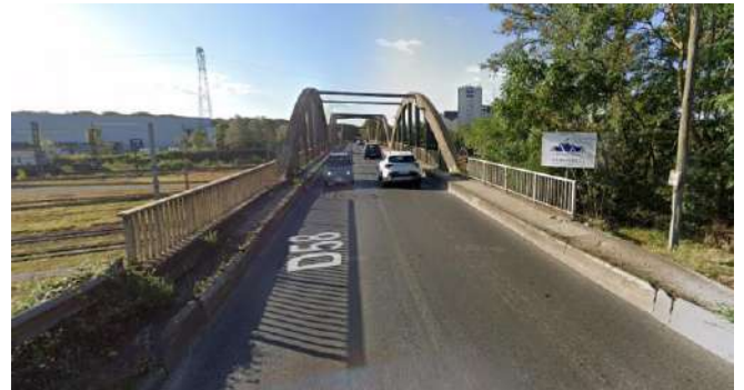
6. Entrée de l'ouvrage de franchissement des voies ferrées
