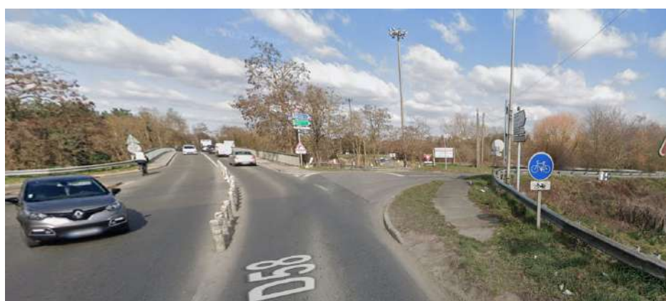
Figure 9 : Visibilité sur la bretelle d'insertion RN10 / Accès Technicentre
