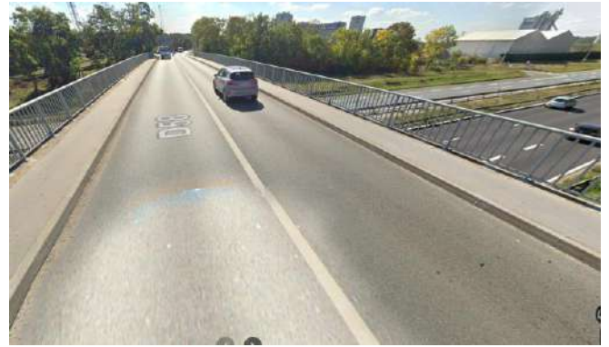
5. Ouvrage de franchissement de la RN10
