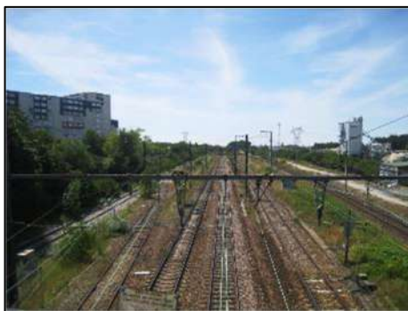
Photo 1 : Aperçu des voies ferrées depuis le pont de la Villedieu (Source : Iris Conseil, juillet 2019)
