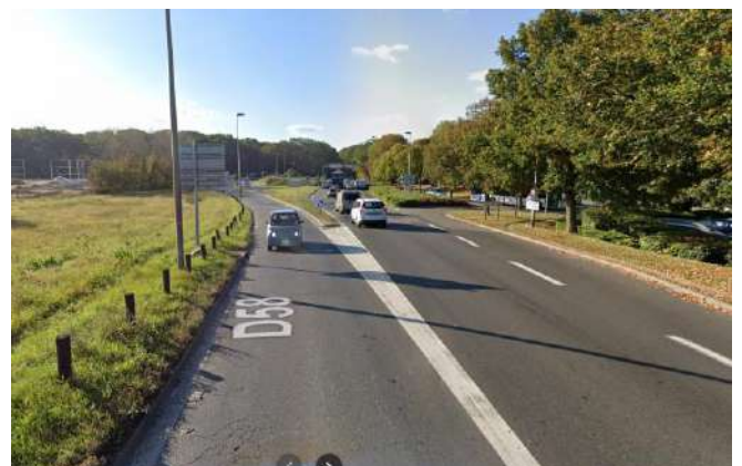
8. RD58 Sud en sortie de l'ouvrage de franchissement des voies ferrées au niveau du quartier du Bois de l'Etang
