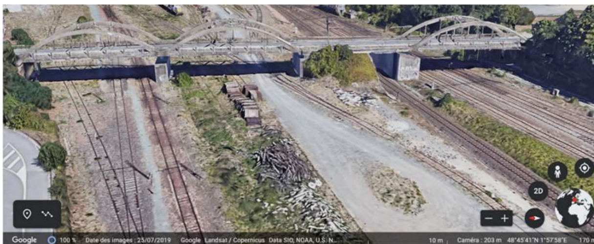
Figure 14 : Vue générale de l'OA SNCF existant – source Google
