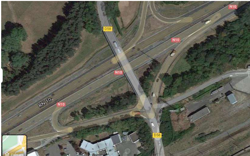
Figure 10 : OA RN10 – Vue aérienne de l’ouvrage existant – source Google
