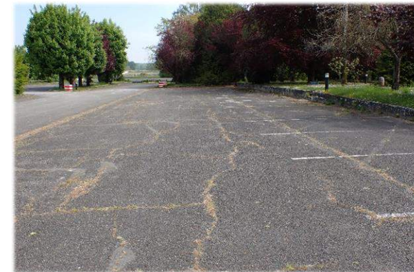
J4.2 - Réseaux routiers
