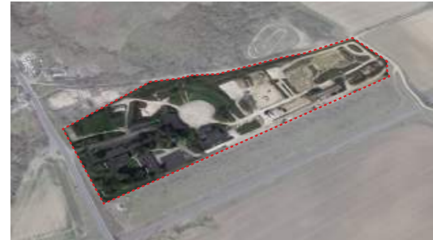
Vue aérienne du site | source Google Earth
