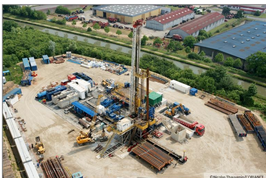
Exemples d'un chantier de forage au Dogger (CFG)
