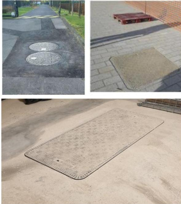
**FIGURE 29 : EXEMPLES DE TAMPONS AU DROIT DES CHAMBRES DE FORAGE**
