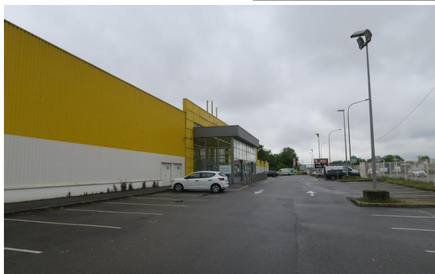
8 : Vue sur la façade principale du bâtiment existant avec son SAS d'entrée qui sera démoli (prise de vue du 30 avril 2024)
