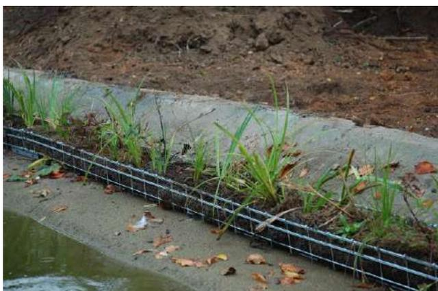
Structure métallique « chemin de cable » électro zingué avec mottes pré-cultivées (lac des Ibis – Vésinet)
