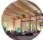
Plancher bois-béton connecté sur poteaux et poutres bois
