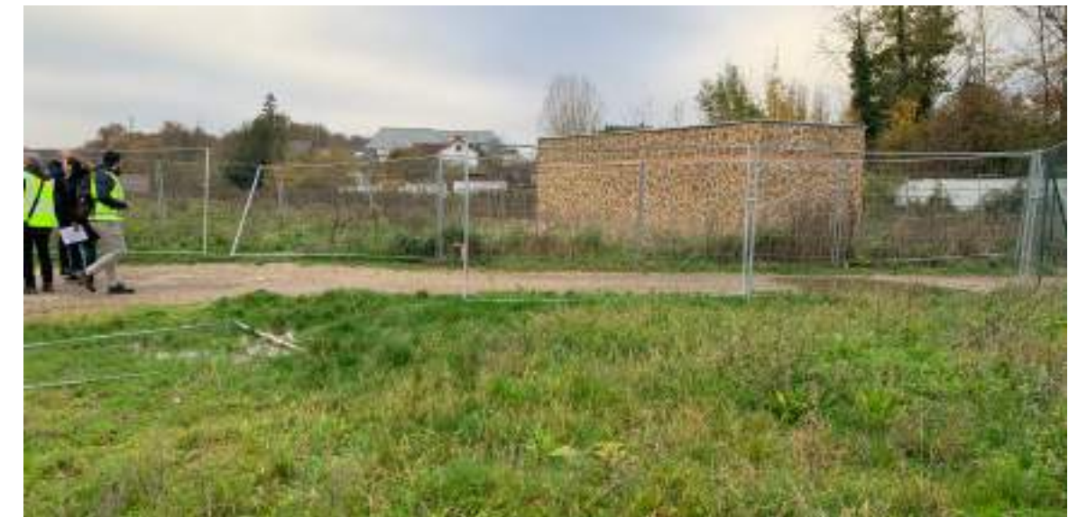
4 - Orientation vers le sud, vue sur édifices de sortie de secours
