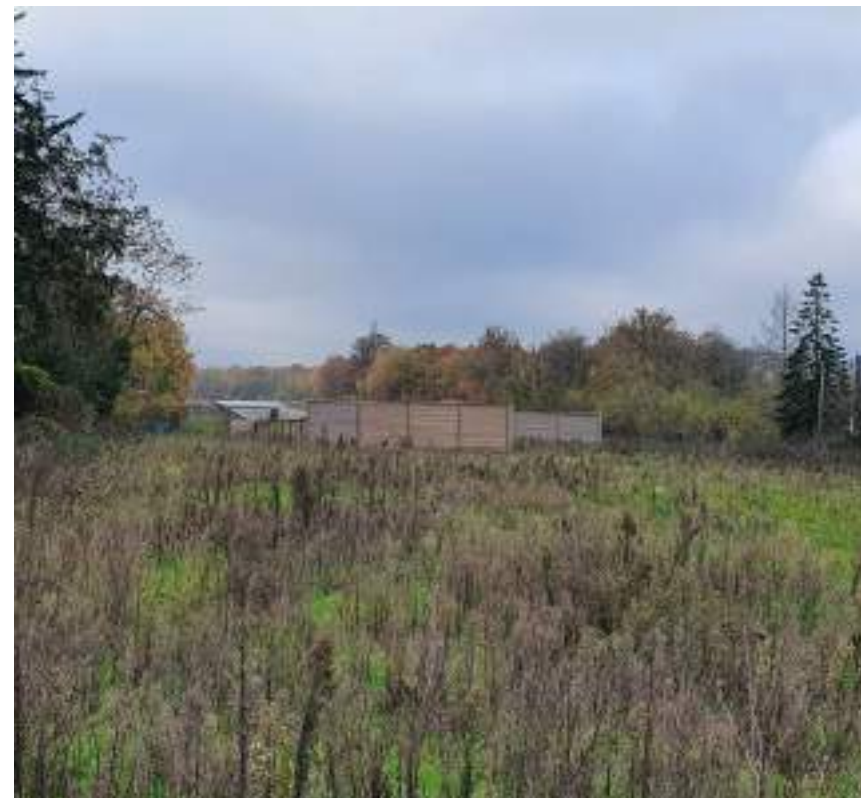
1 - Vue sur la sortie de tunnel
