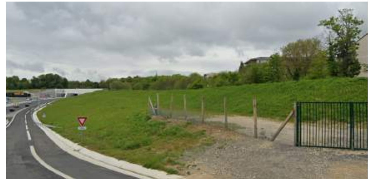
4 - Accès aux chemins d'entretien des talus ouest depuis la RN19 nord
