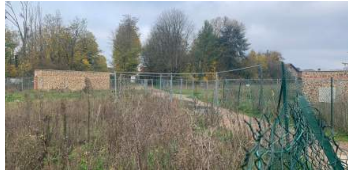
4 - Vue édicules de sortie de secours
