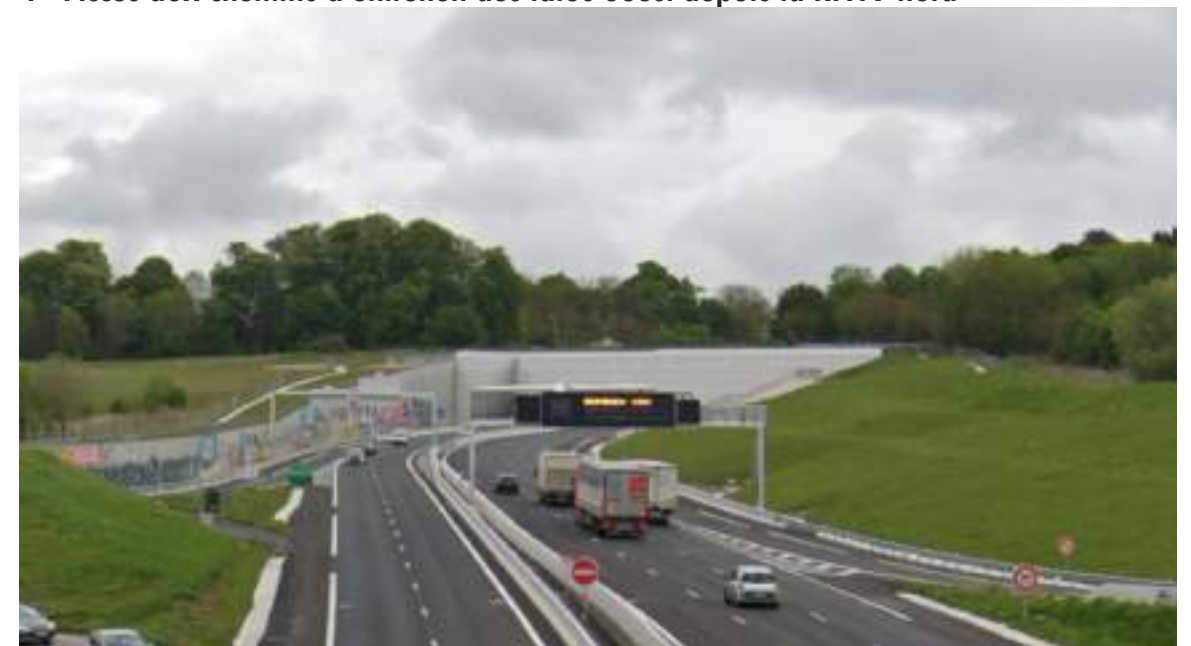
5 - Vue sur les talus de la séquence A depuis le franchissement allée des FFV
