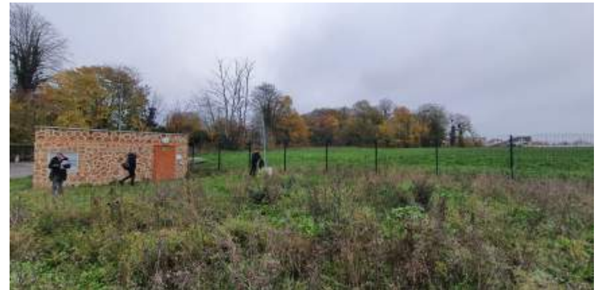
5 - Orientation vers l'est, vue sur édicule de sortie de secours
