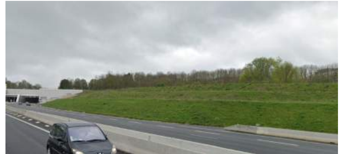
3 - Vue sur le talus ouest depuis la RN19
