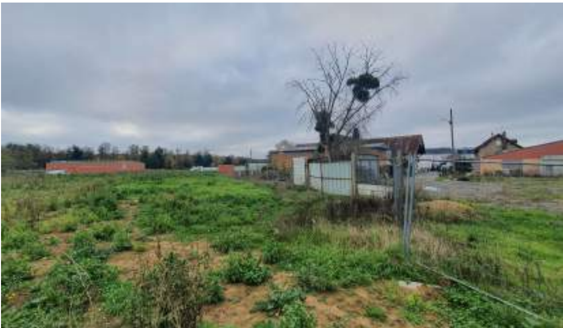
4 - Vue sur prairie existante et édicules de sortie de secours
