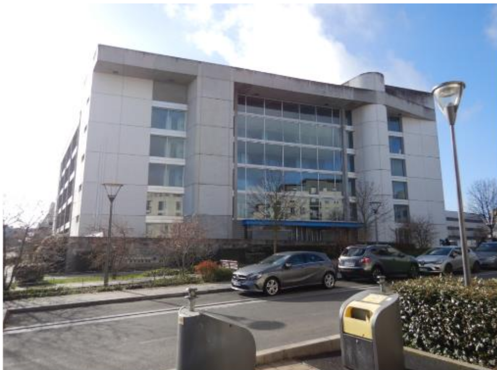
Photographie 9 : Site depuis la rue Magellan au Nord
