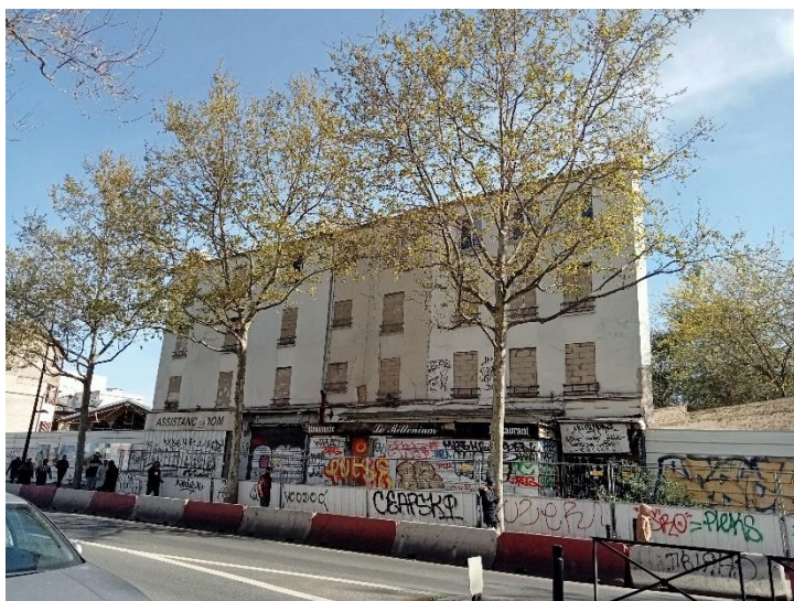
14. Station Total ; programmé en démolition
